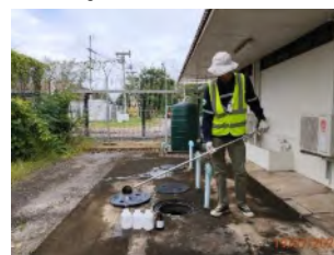
บ่อพักน้ำทิ้งหลังผ่านระบบบำบัดน้ำเสียของอาคารที่พักผู้โดยสาร
