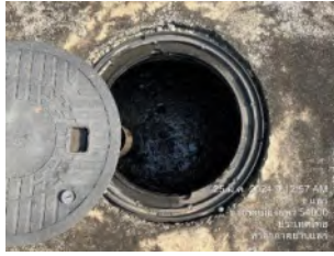
บ่อพักน้ำทิ้งก่อนผ่านระบบบำบัดน้ำเสียของอาคารที่พักผู้โดยสาร
