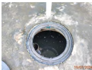
บ่อพักน้ำทิ้งก่อนผ่านระบบบำบัดน้ำเสียของอาคารที่พักผู้โดยสาร
