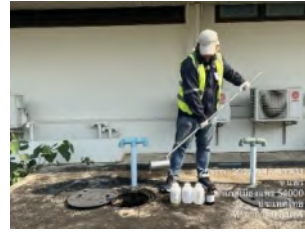
บ่อพักน้ำทิ้งก่อนผ่านระบบบำบัดน้ำเสียของอาคารที่พักผู้โดยสาร
