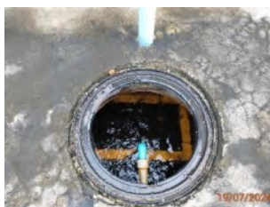
บ่อพักน้ำทิ้งหลังผ่านระบบบำบัดน้ำเสียของอาคารที่พักผู้โดยสาร
